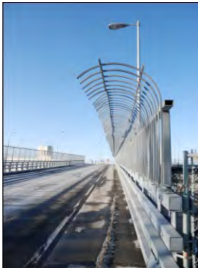
La barrière de sécurité du pont Jacques-Cartier, à Montréal, fut installée pour prévenir les actes de suicide.
